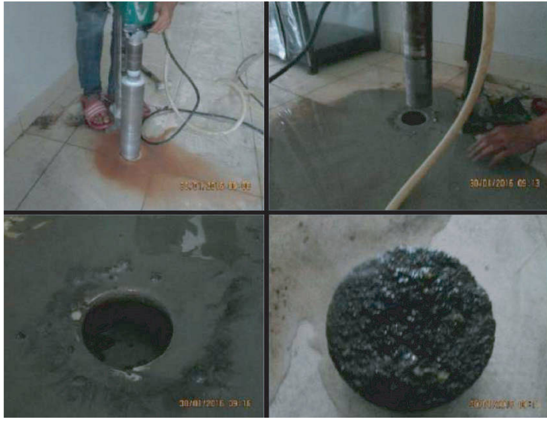
PT. Persada Sokka Tama - Coring Test Ruko Celeb Boulevard Bekasi 2016
